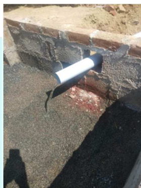
L'eau du toit du Centre Rajam se dirige dans le puits en passant par un filtre à sable
